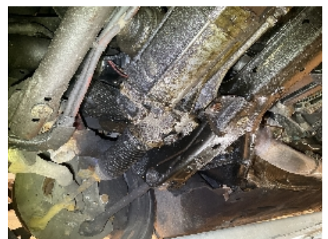
60. Utvendig tilstand motor
